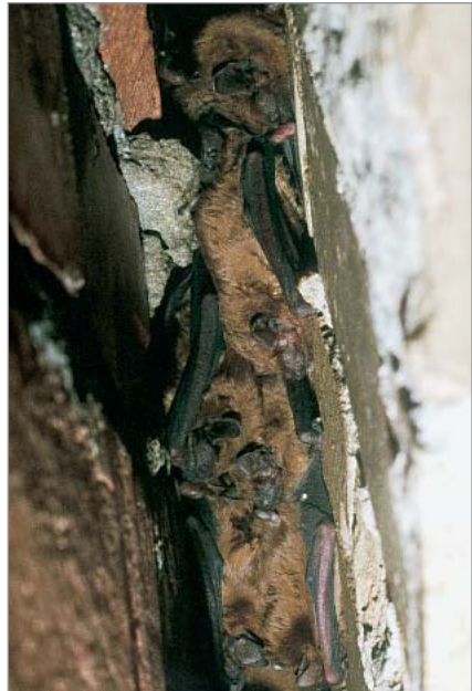
Bis zu 1m tief kriechen die Abendsegler zum Winterschlaf in die Dehnungsfuge der Levensauer Hochbrücke.
