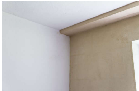
Bild 3 noch nicht gestrichene Innendämmung
