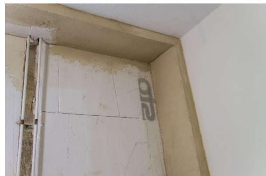
Bild 2 noch nicht vollständig verputzte Innendämmung
