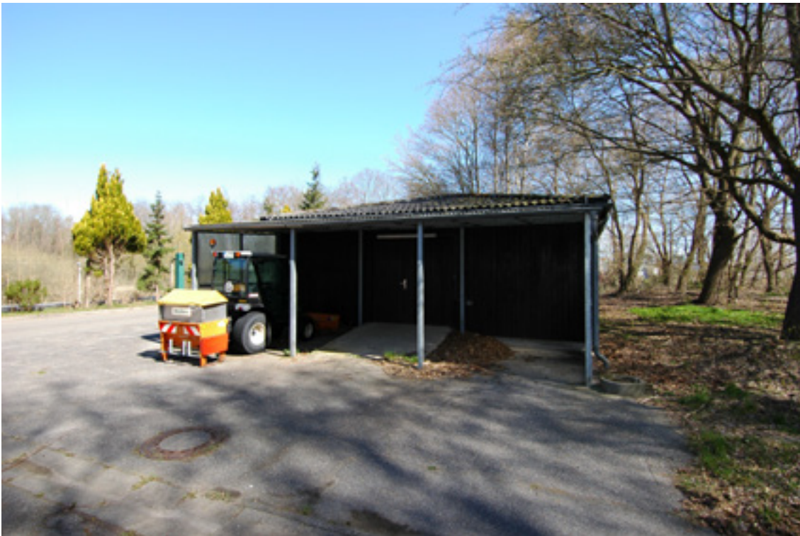
Abbildung 11: Gebäude B2, Lagergebäude, Westfassade
