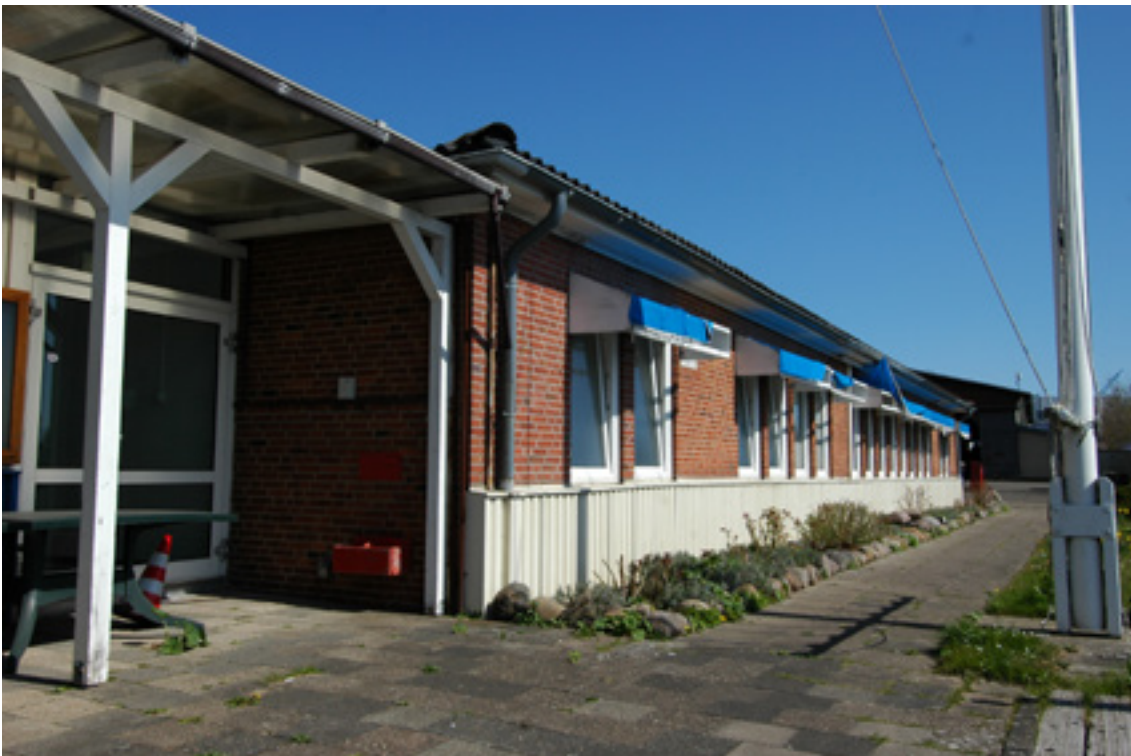
Abbildung 24: Gebäude B3, Bürogebäude, Südfassade
