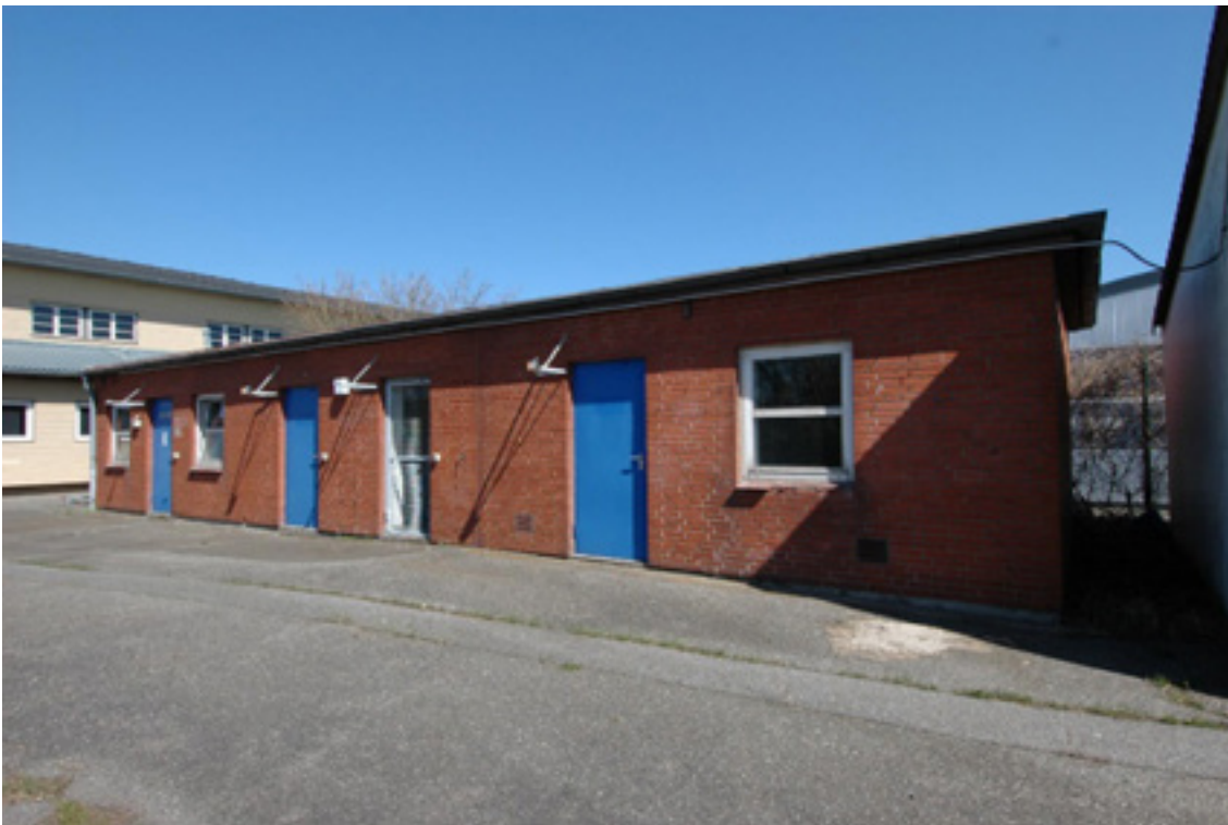
Abbildung 38: Ehemaliges Batterielager, Außenansicht
