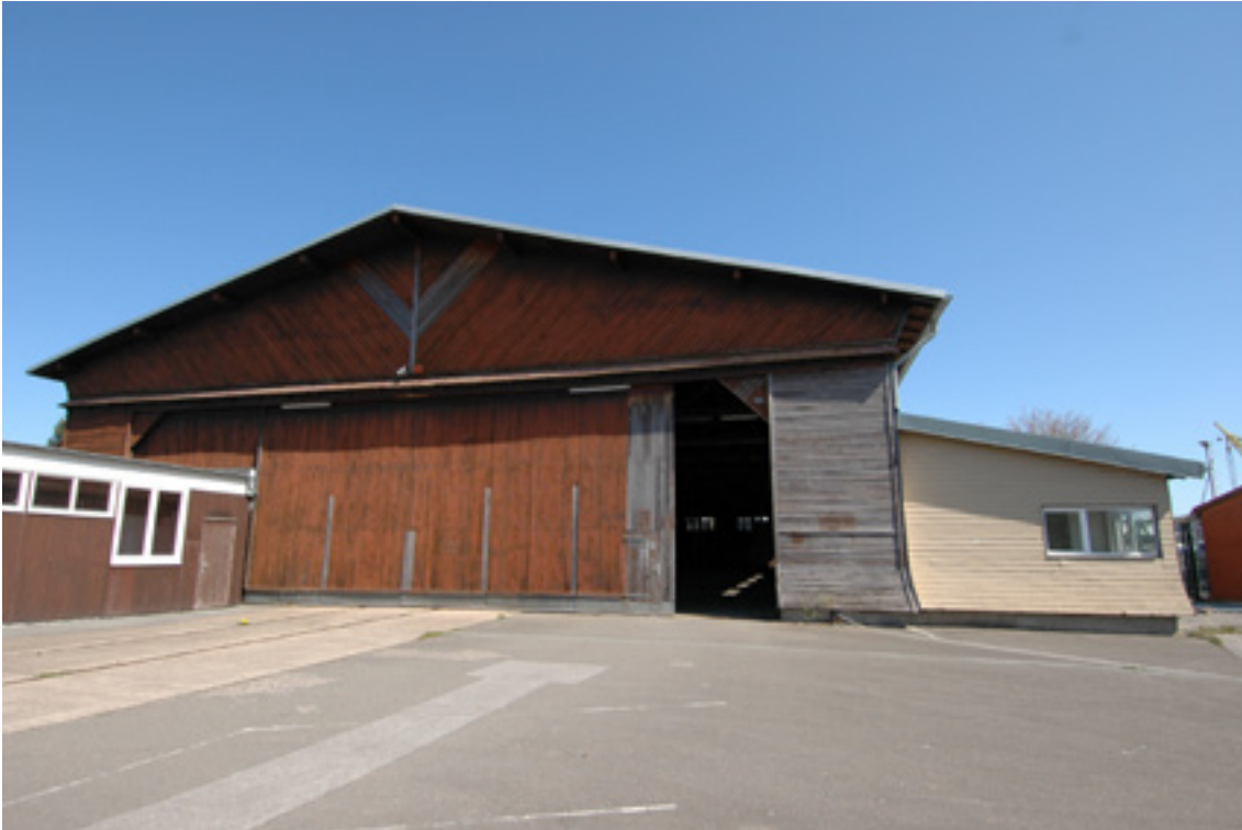
Abbildung 31: Gebäude 4, Holzhalle, Außenansicht
