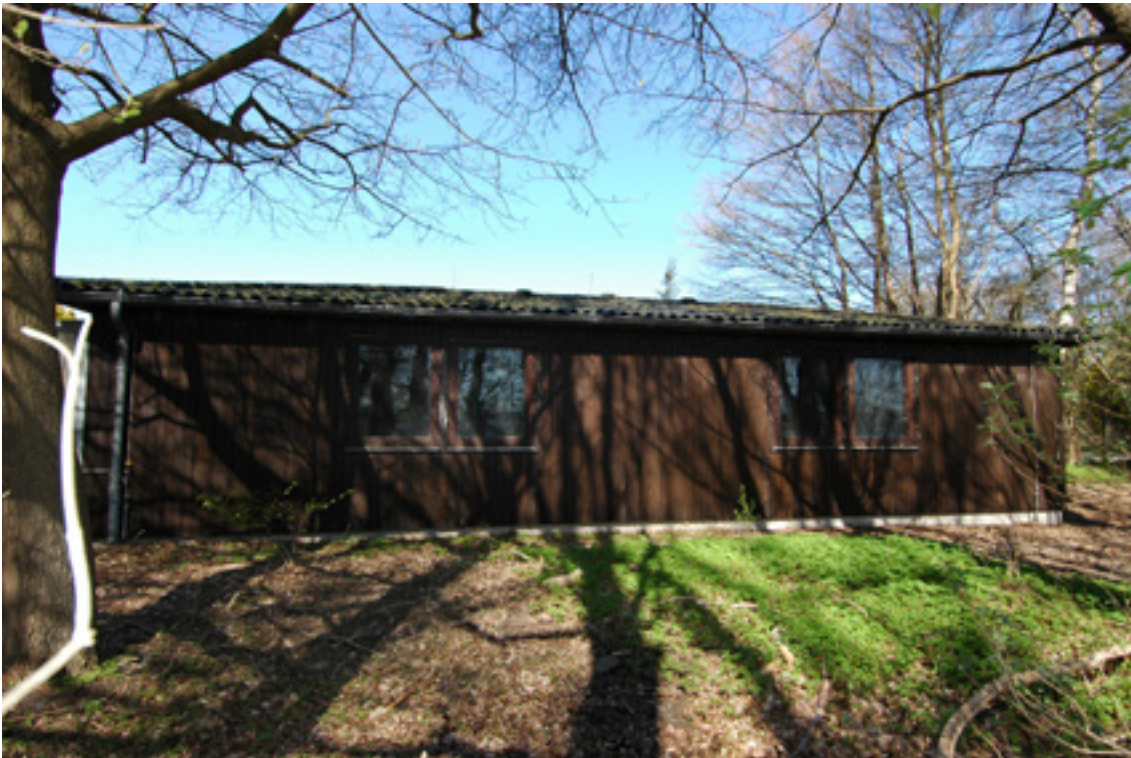
Abbildung 14: B2, Lagergebäude, Südfassade
