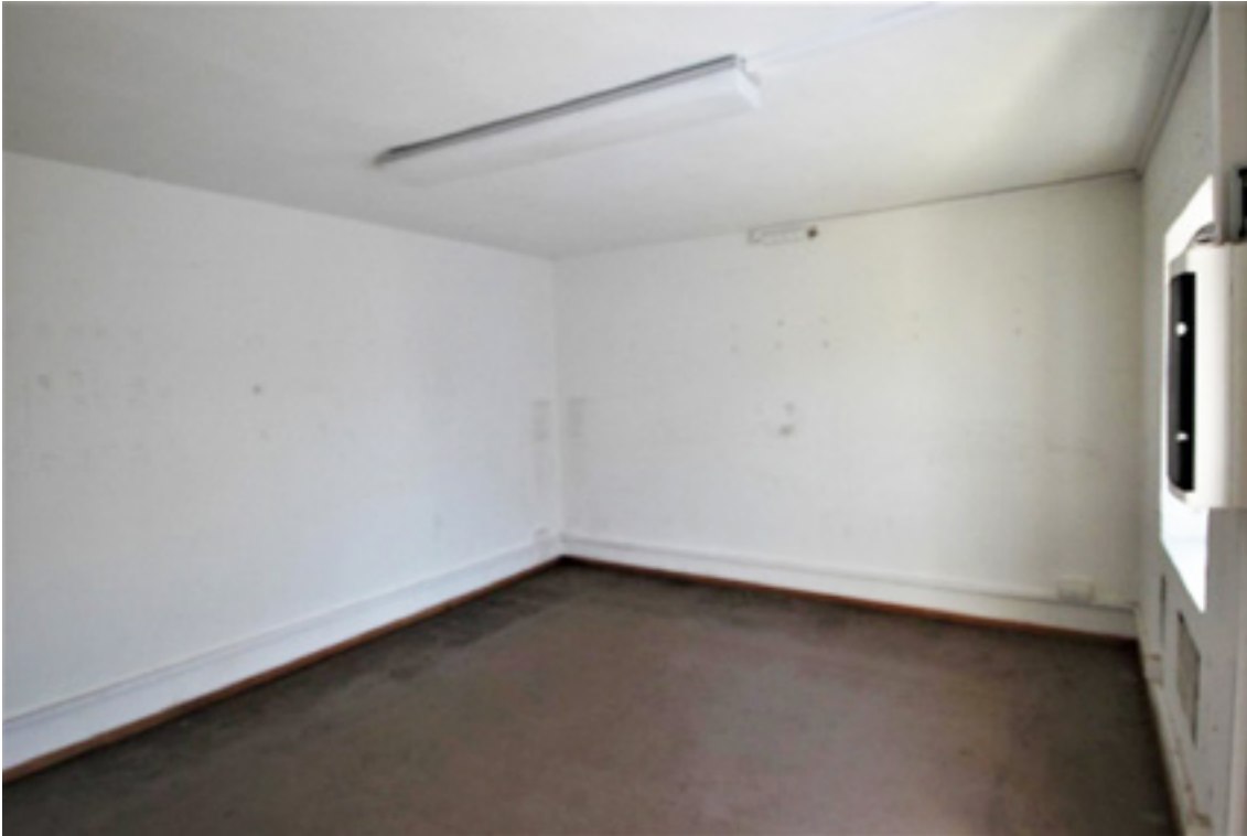
Abbildung 39: Ehemaliges Batterielager, Lagerraum 1
