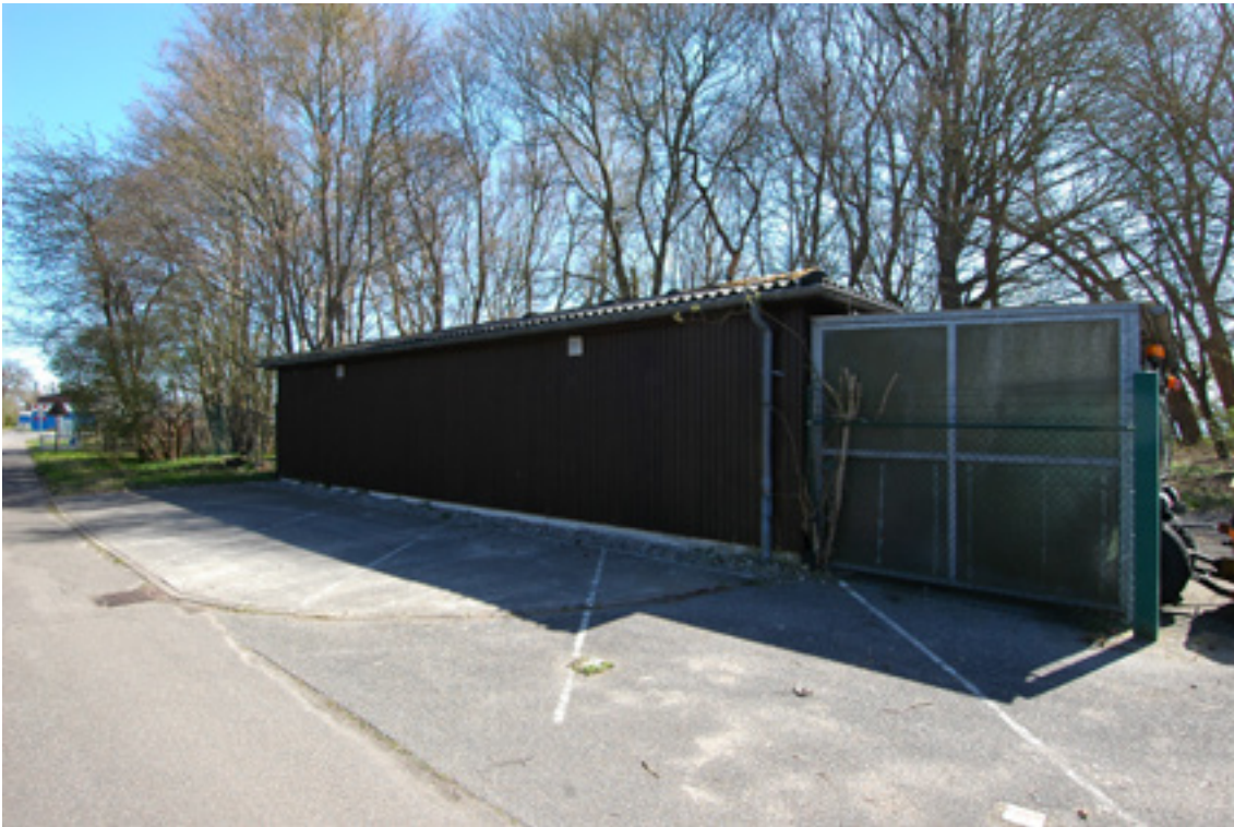
Abbildung 12: B2, Lagergebäude, Nordfassade
