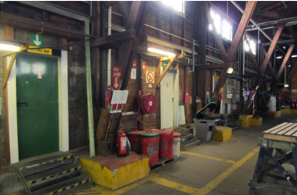
Abbildung 33: Gebäude 4, Holzhalle – Zugänge zu den Räumen im Anbau, Gebäude 4a
