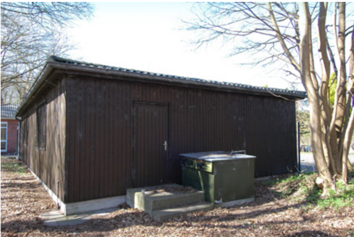
Abbildung 13 B2, Lagergebäude, Ostfassade
