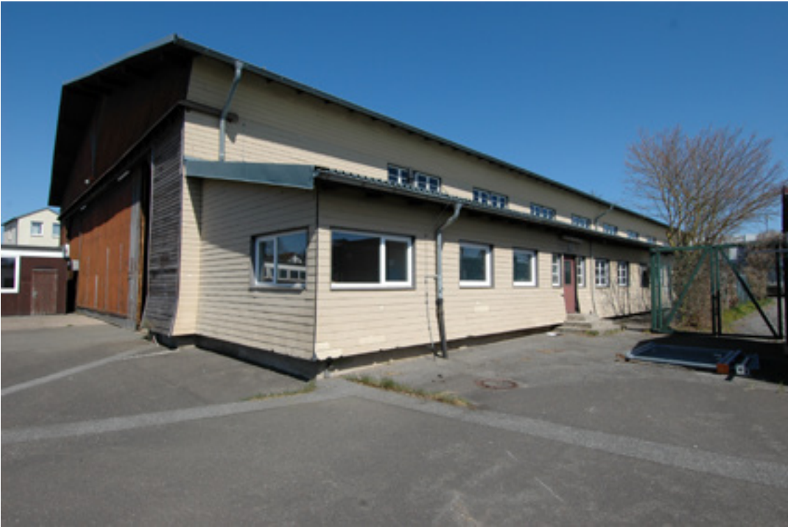
Abbildung 35: Gebäude 4a, Ansicht Süd-West
