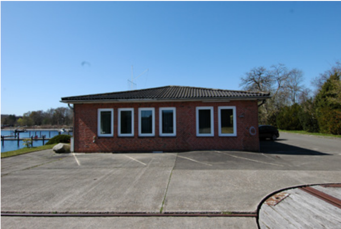
Abbildung 25: Gebäude B3, Bürogebäude, Ostfassade
