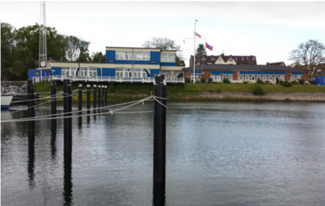
Abbildung 16: Gebäude B3a, Kantine und 3, Bürogebäude, Südfassaden (2015)
