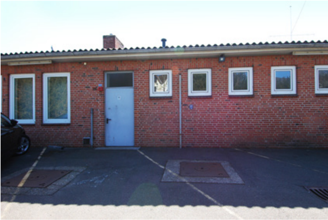
Abbildung 29: Gebäude 3, Nordfassade, Zugang Heizungsraum von außen
