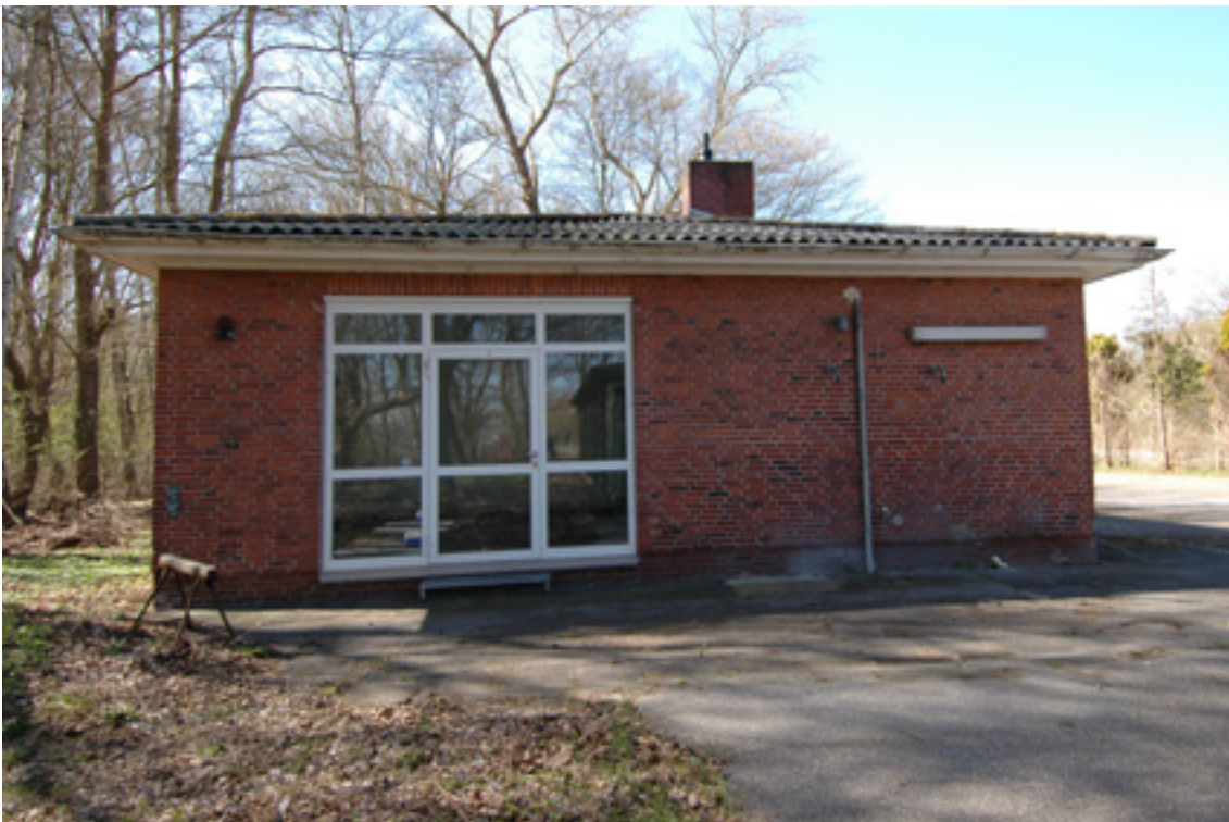
Abbildung 3: Gebäude B1, Schulungsgebäude, Ostfassade
