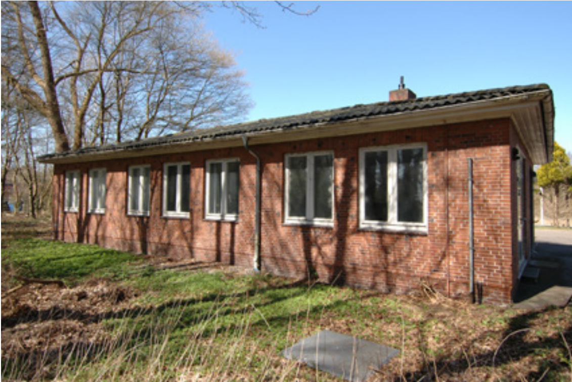
Abbildung 4: Gebäude B1, Schulungsgebäude, Südfassade
