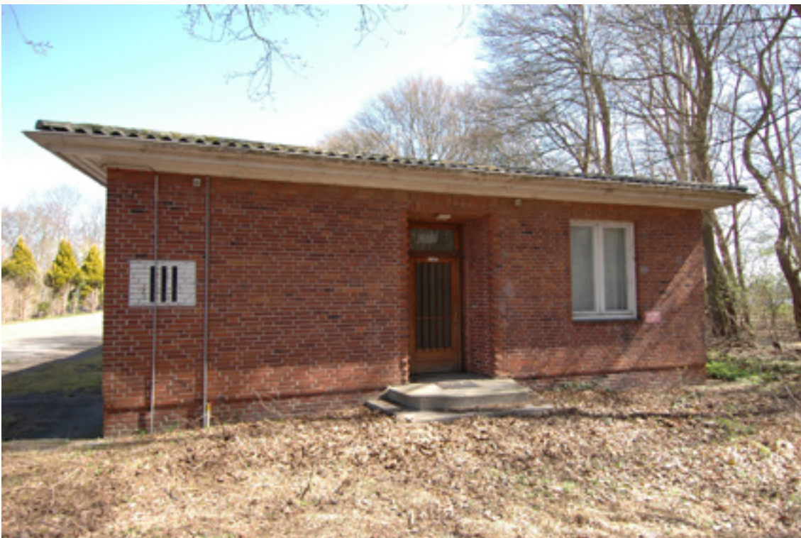
Abbildung 1: Gebäude B1, Schulungsgebäude, Westfassade, Eingang
