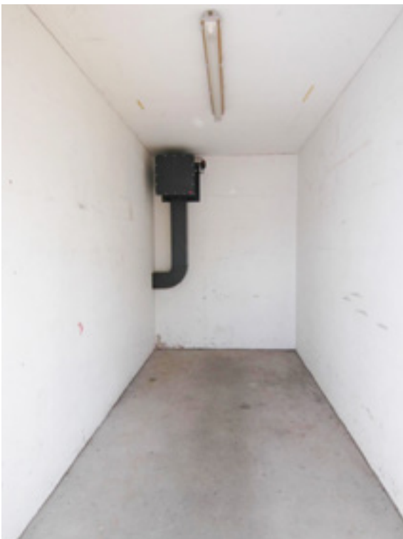
Abbildung 40: Ehemaliges Batterielager, Lagerraum 2
