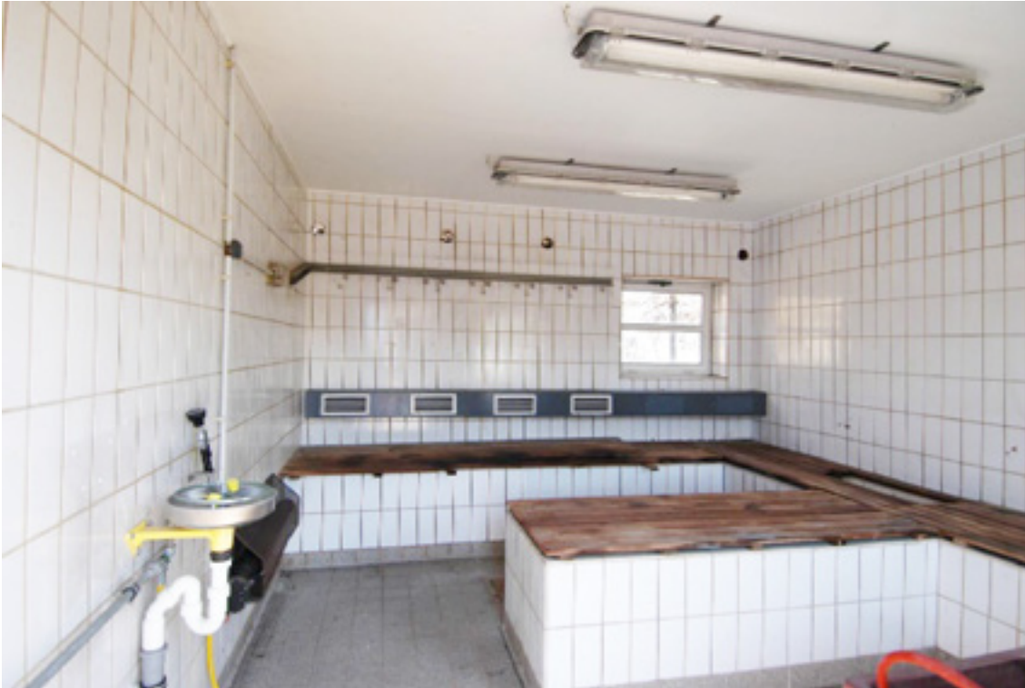
Abbildung 41: Ehemaliges Batterielager, Lagerraum 3
